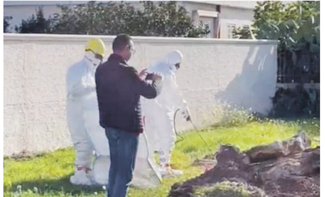
LEPORANO Gli ispettori al lavoro nel cantiere
